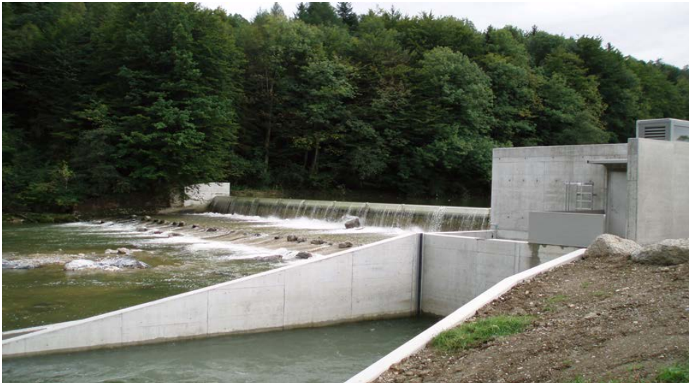
Kraftwerkstufe mit Maschinenhaus
