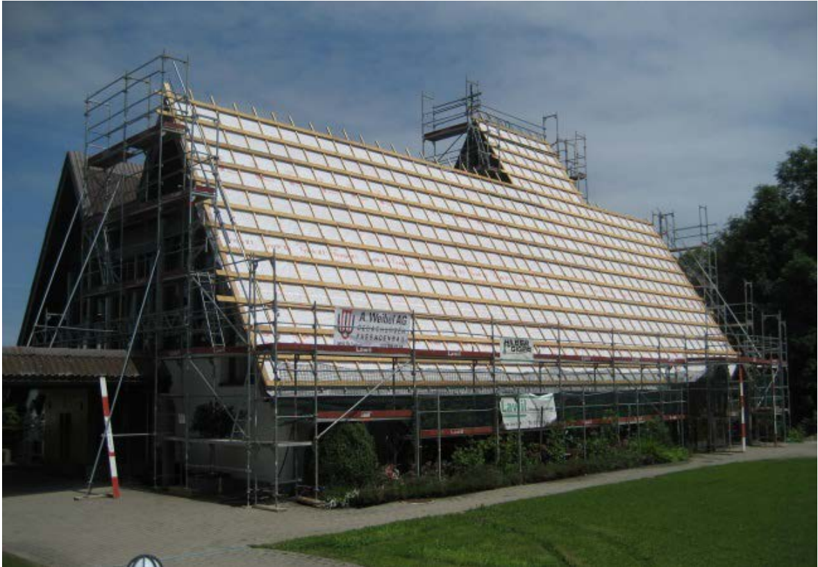
Vorbereitungsarbeiten für die Montage der Solarmodule
