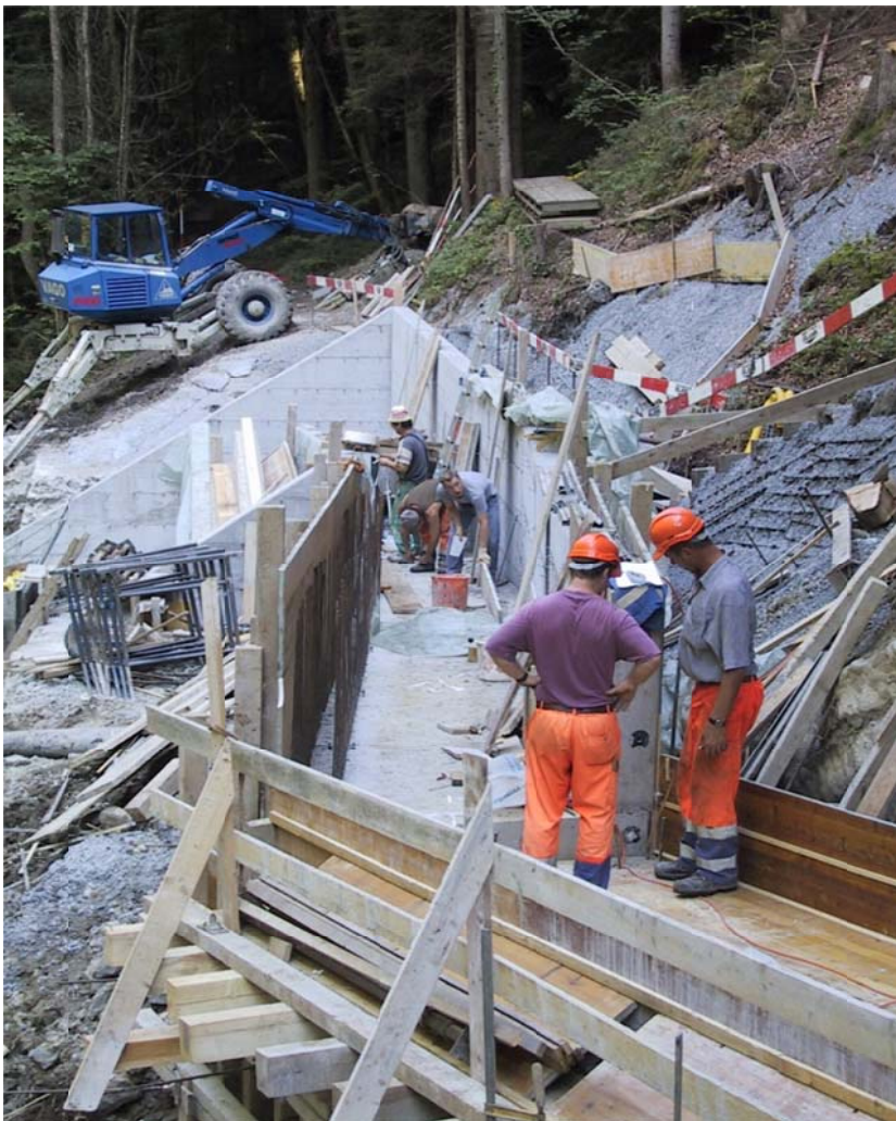
Fischtreppe im Bau beim Wehr Achmühle
