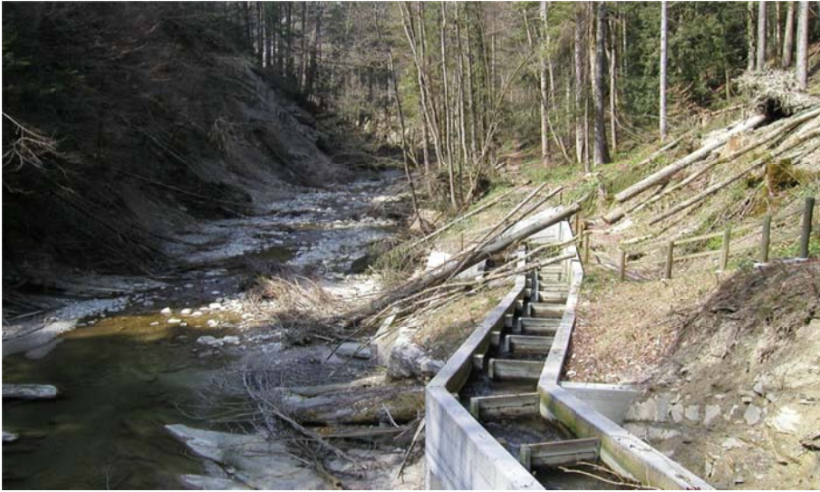
Fertiggestellte Fischstiege Achmühle
