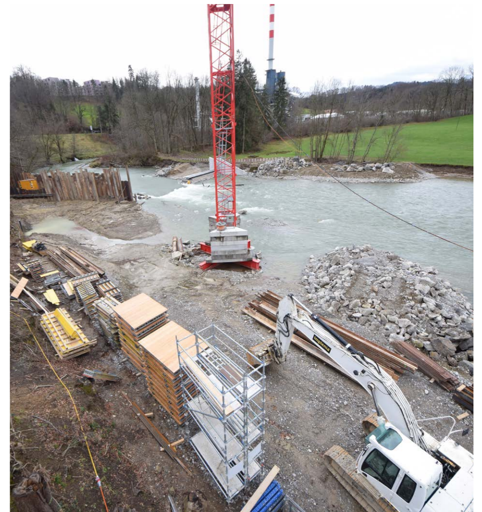
An der Sitter entsteht das neue Kleinwasserkraftwerk Grafenau.
