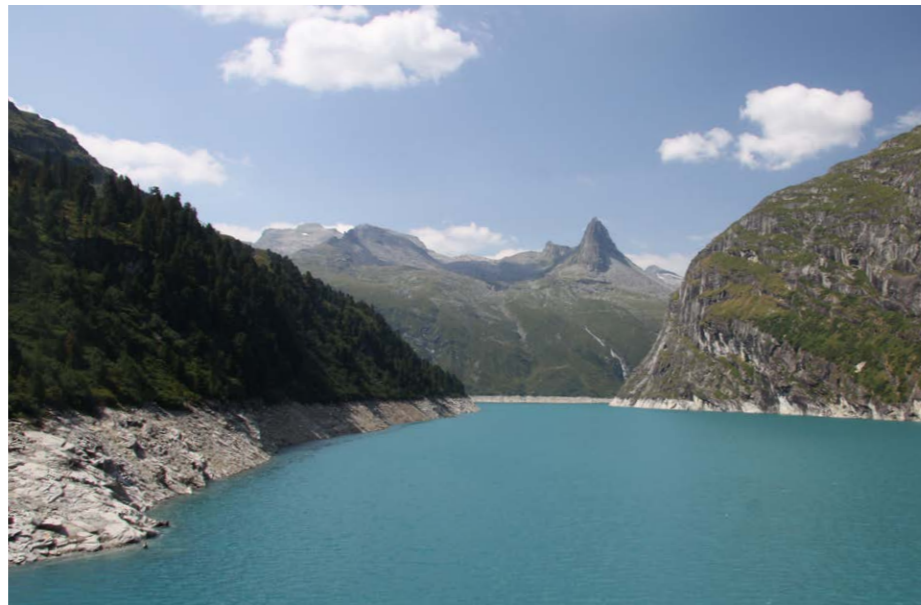
Speichersee Zervreila mit einem Fassungsvermögen von 100 Millionen Kubikmeter Wasser.
